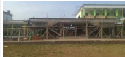
Pembangunan Gd. Sewindu Lt. 1 dan tangga
