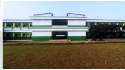
pembangunan Gd. Sewindu Lt. 2 dan tangga
